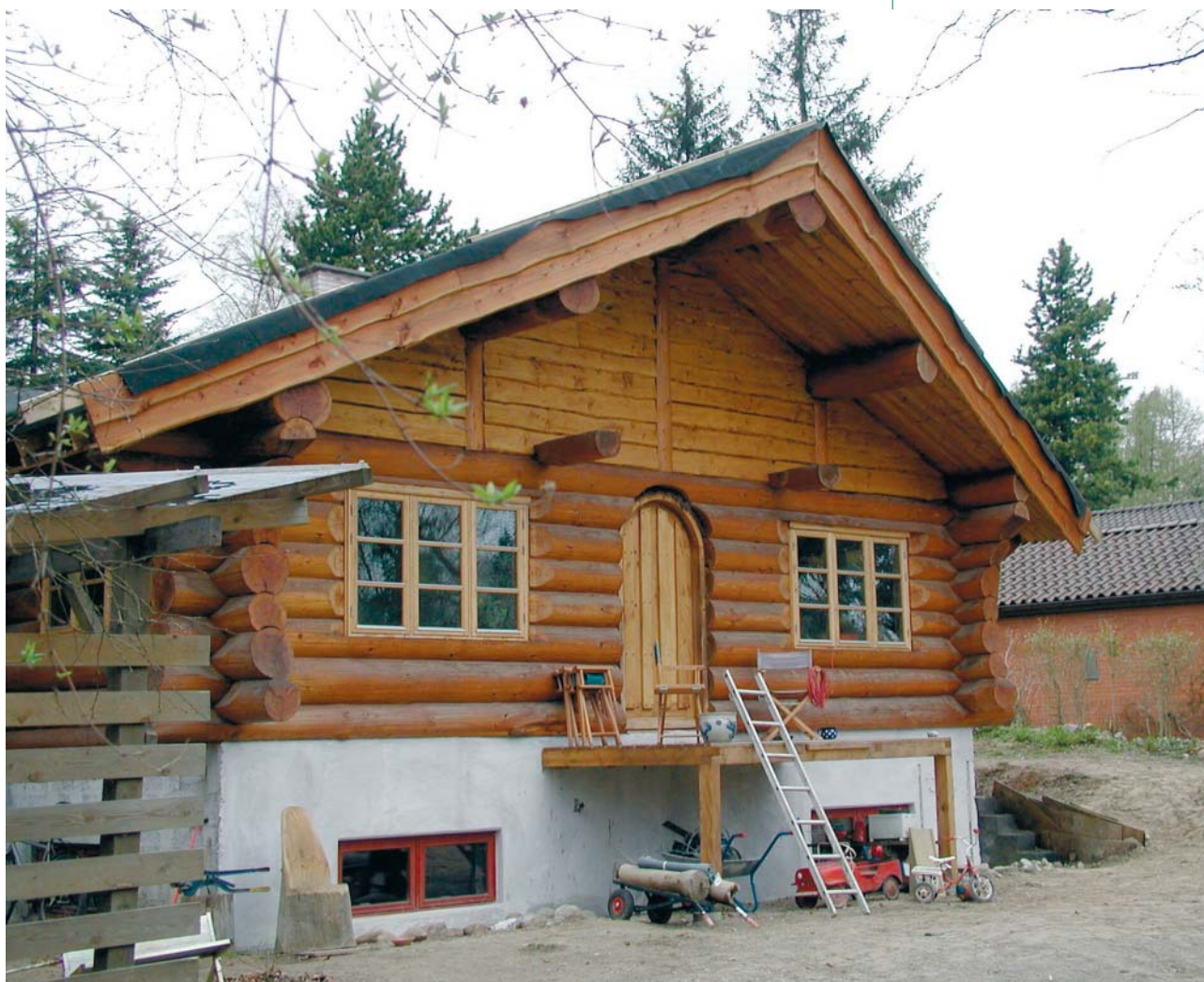
Blokhus lavet med sadelknuden (bygget af Andreas Højgaard)
