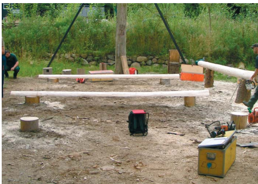
De to første stokke i bundskiftet lagt ud med begge topender til samme side (venstre)
