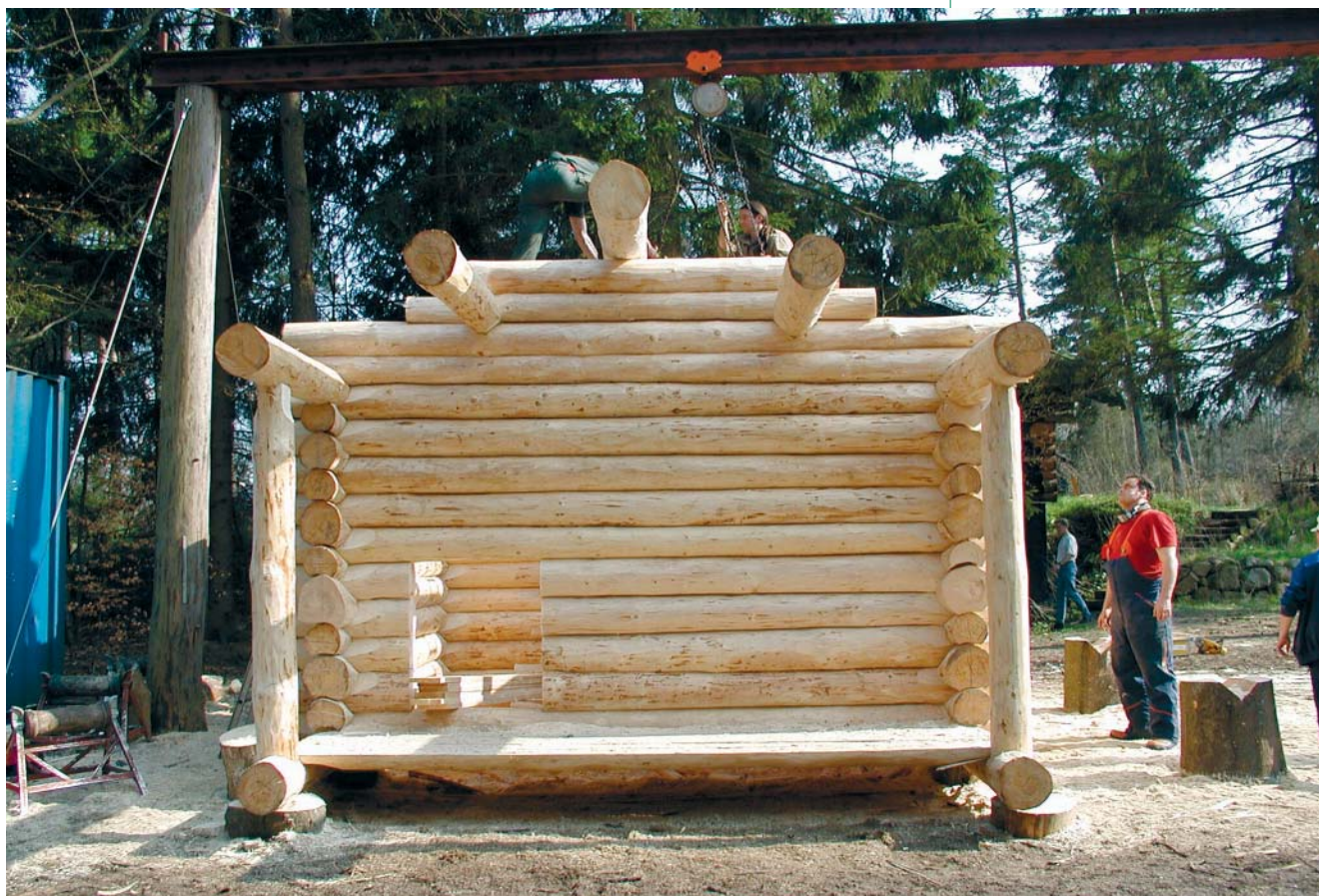
Traverskran med løbekat
