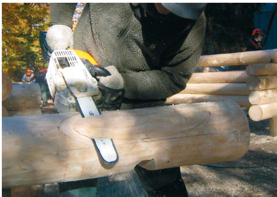
Skæring af sadlen – brug gerne et længere sværd og en større sav
