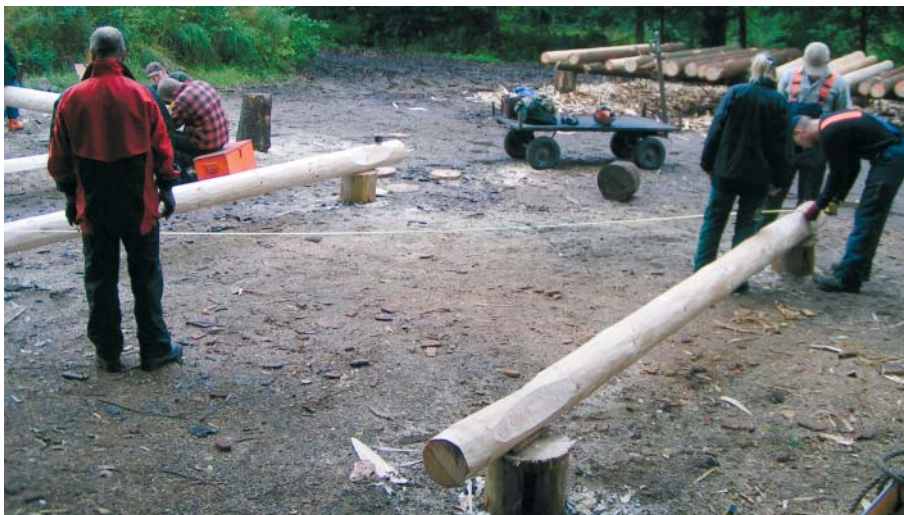
Justering af vinkler i fundament/bundskifte
