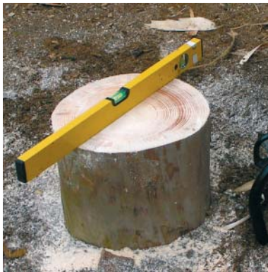
Udvatring af fundamentpæl
