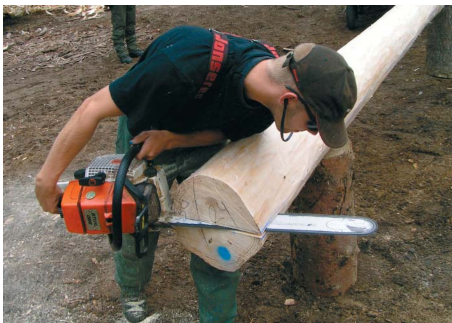
Zigzag-skæring ved deling af bundstok – bemærk at der kun skæres i den side hvor man samtidig kan se stregen
