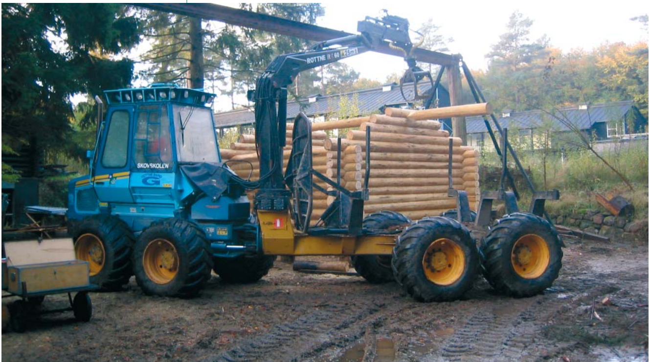
Udkørselsmaskine i brug på byggepladsen.
