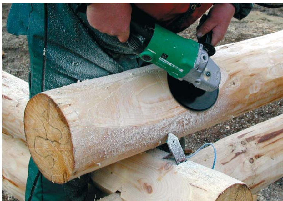
Afpudsning af sadlen med vinkelsliber med pudseskive
