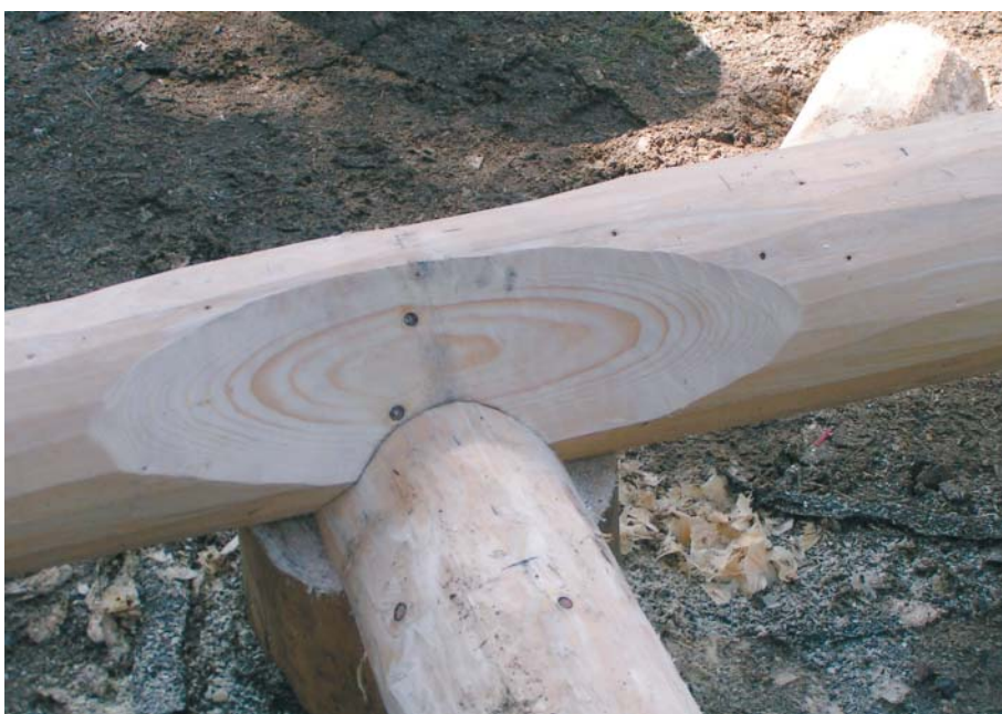
Skjult stokende i bundskiftet lavet med rund knude (der er ingen sadel på den underste stok)
