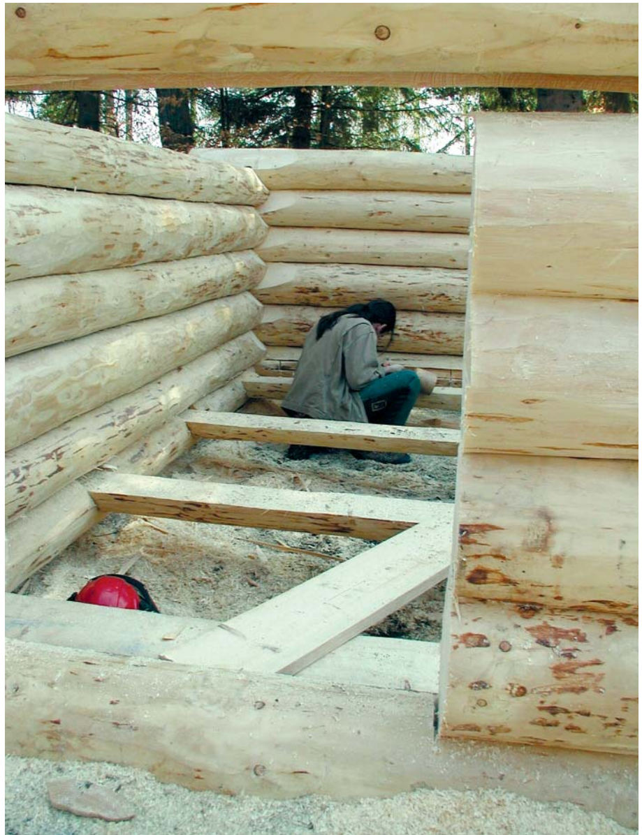
Strøer til gulvplanker lagt ind i bundskiftet og kursist der skærer rille til indfældning af gulvplanker.
