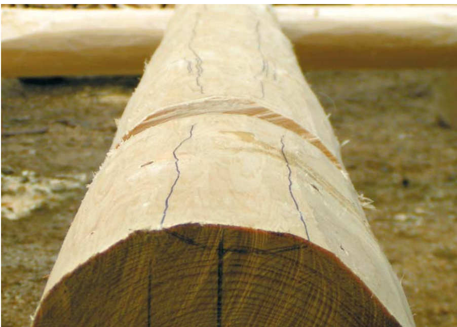
Opstregning til udskæring af grøft
