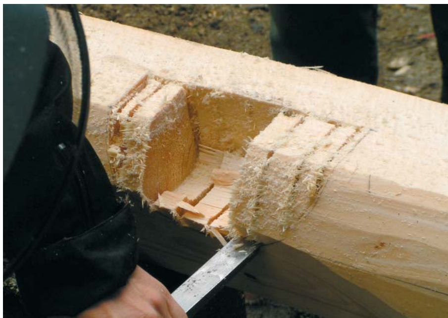
Udskæring til skjult stokende – bemærk at der ikke er skåret helt ud til stregen
