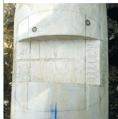
Opmærkning af den næstøverste stok
